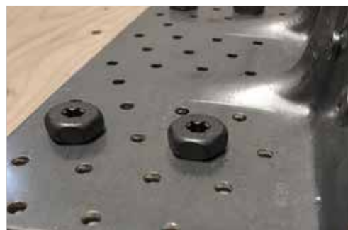
Bevestiging van een ABR255-hoekijzer
