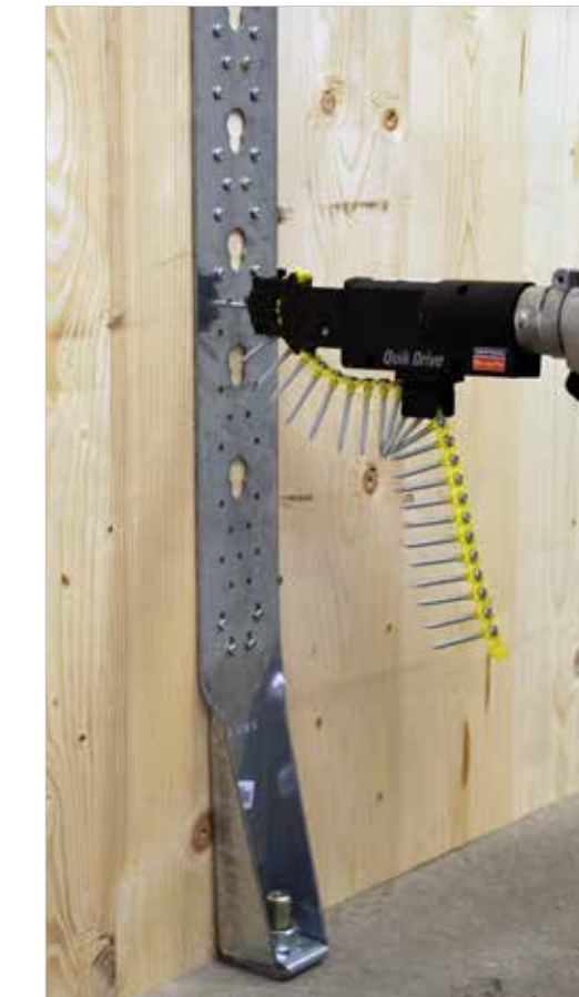
HTT31-anker bevestigd met CSA-bandschroeven voor de verbinding van een wand van dwarsgelamineerd hout op een betonplaat
