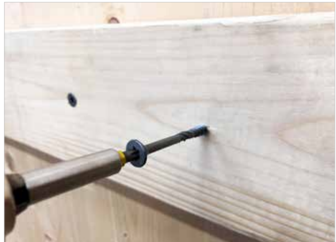
Ligger bevestigd met TTZNFS-schroeven
