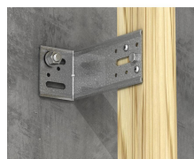
Bevestiging van de houten kepers
