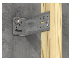
Bevestiging van de houten kepers
