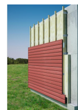
Plaatsing van een regenkap
