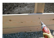
Bevestiging van houten elementen voor buitengebruik
