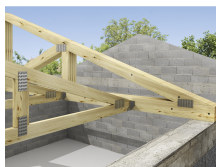
Verbinding van de kappanten
